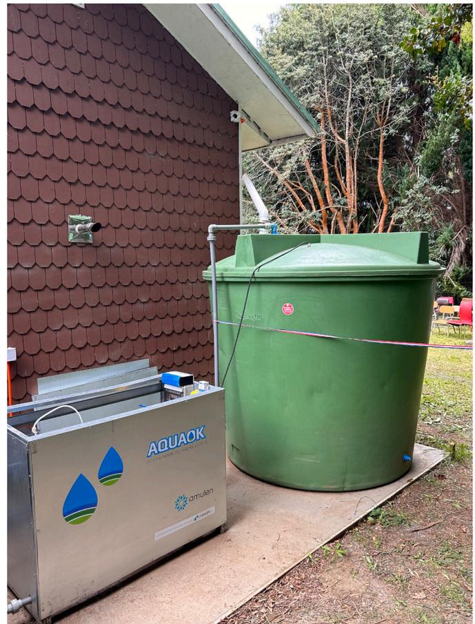
tratamiento que contiene un filtro mecánico, uno de carbón activado y uno ultravioleta para finalmente ser clorada mediante una bomba dosificadora de cloro que inyecta pulsos a la red. Luego, el suministro fluye hacia un estanque de agua potable que debe cumplir con los requerimientos impuestos por la autoridad sanitaria (norma chilena NCh409). Finalmente, a través de una electrobomba periférica, se inyecta a la red de agua potable del establecimiento complementando al suministro principal.
